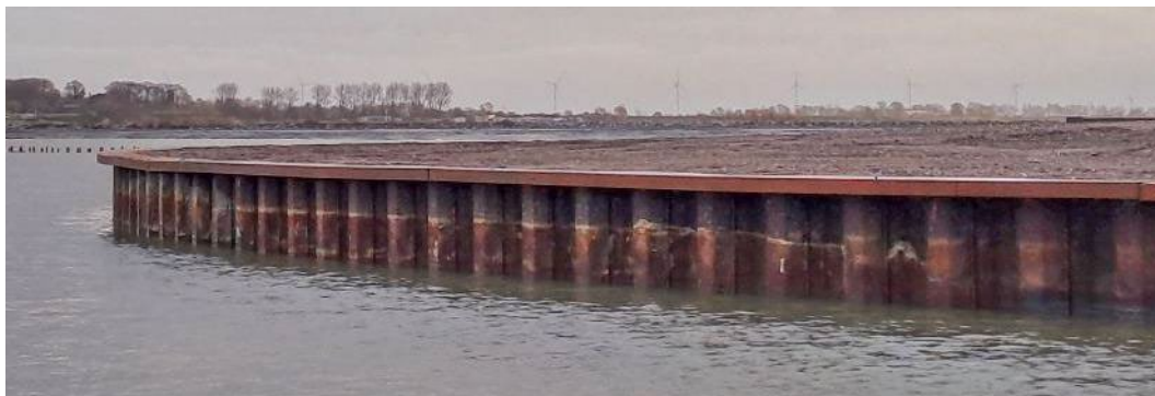
Figuur 3.10. Broedfort Amstelmeer. De stalen damwand moet de toegang voor grondpredatoren belemmeren (foto: Roelf Hovinga).
