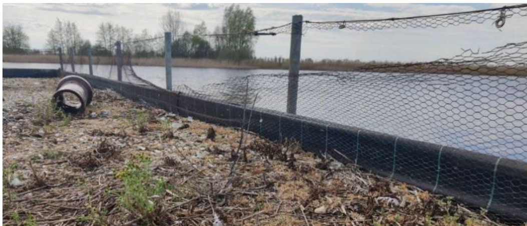
Figuur 3.20. De staat van het vlot in de Zwagermieden op 15 april 2025. Het gaas was grotendeels gescheurd. Daarnaast groeide er diverse soorten vegetatie op de oorspronkelijke kale schelpen/grindlaag (foto: Petra Manche).
