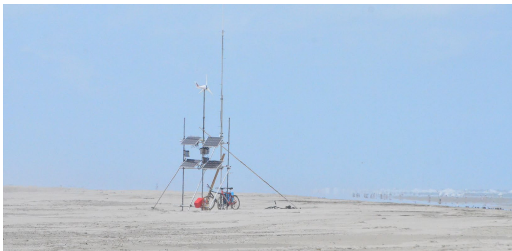
Figuur 5.22. WATLAS ontvangststation op de Balg van Schiermonnikoog. Een windmolen en zonnepanelen zorgen voor de stroomvoorziening (foto: Sjoerd Duijns).
